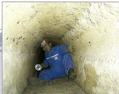
Visite de l'intérieur de la galerie en béton coffré avec 50 cm de limon sous les fesses, il reste 80 cm sous la voûte pour progresser
