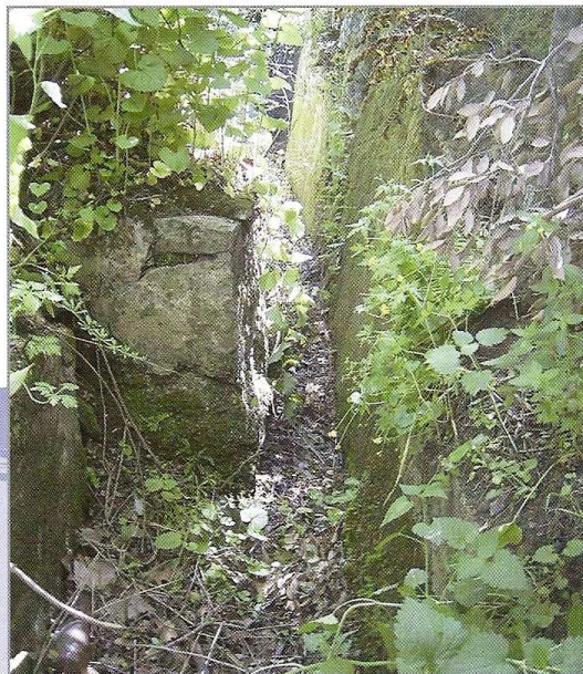
Fin du canal béton et début du canal taillé dans la roche. La largeur diminue de 90 cm à 40 cm
